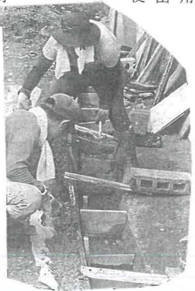
側溝のコンクリートは手ねり、少しずつ埋める。古材の床板を何度も再利用した型枠設計図なしの現場合わせ工事(抄吾と齋藤君)
