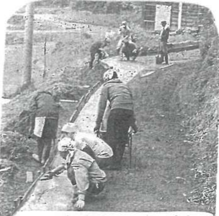
5/21 道路拡張のコンクリート打ちは、一輪車部隊、振動係、大ならし、こて撫ぜとスタッフ総動員
